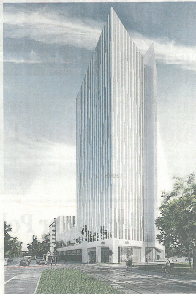
Spät, aber doch: Der viel diskutierte Bulgari Tower wird gebaut.
